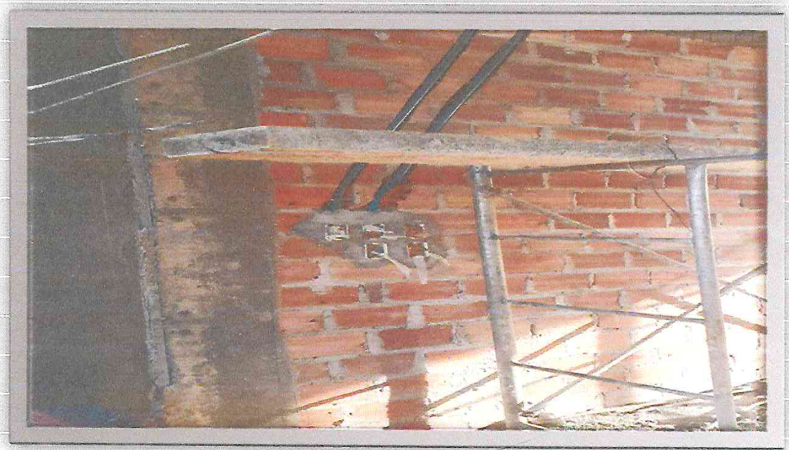
VISTA DE INSTALACION DE CAJAS PARA INTERRUPTORES
