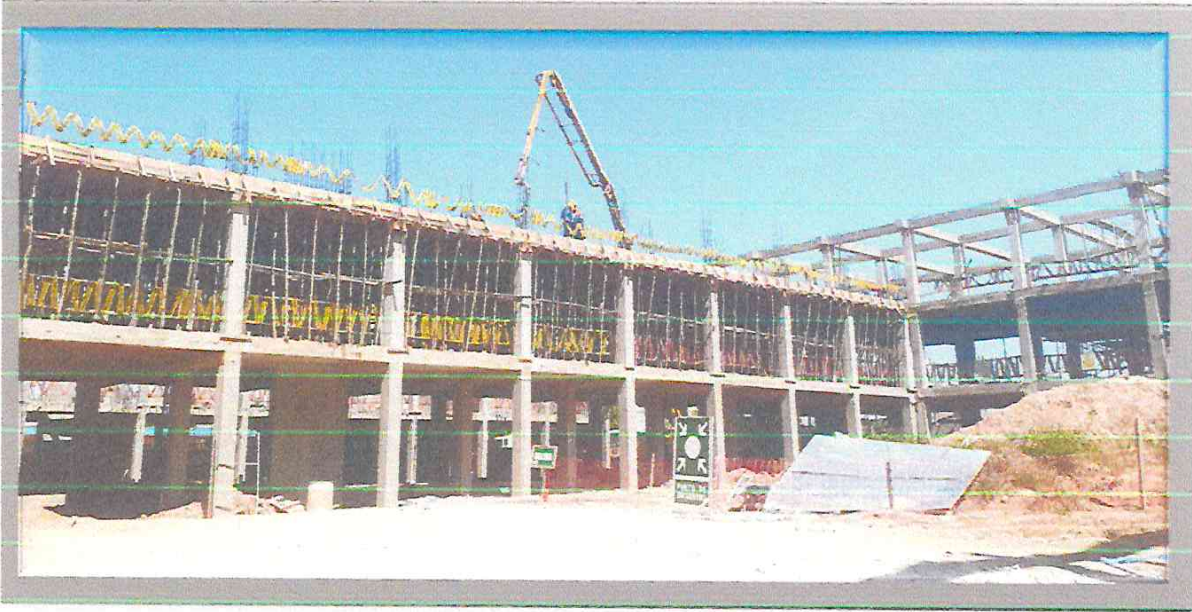
VISTA DE VACIADO DE MORTERO PREMEZCLADO EN LOSA ALIGERADA EN 2° PISO DE MOD "C"
