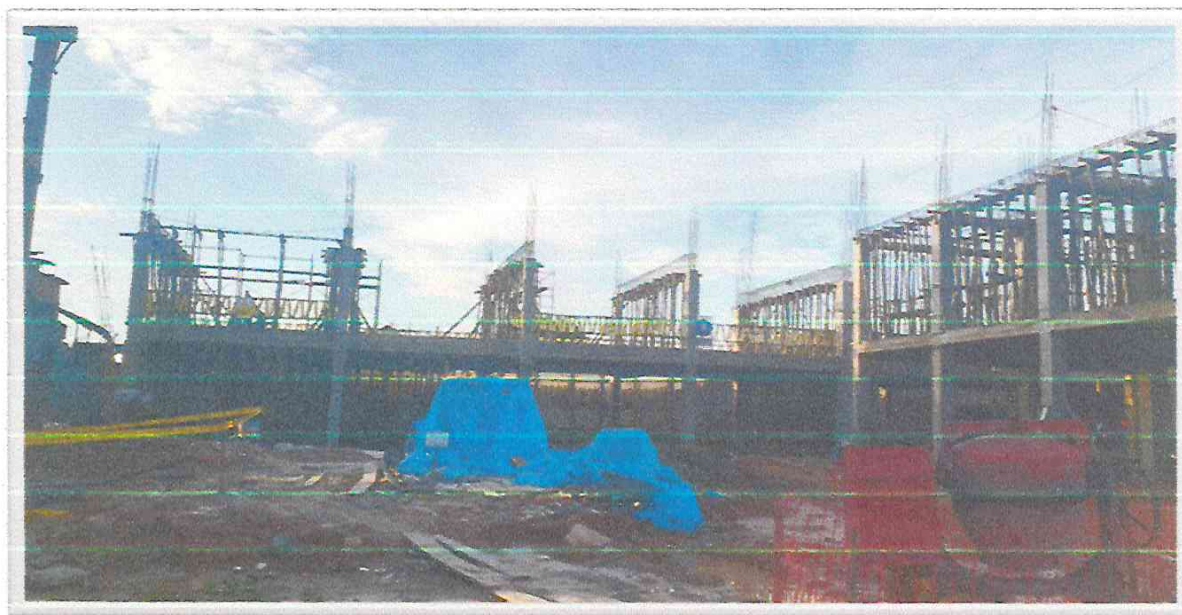
VISTA DE ENCOFRADO DE MADERA DE FONDOS DE VIGAS MOD "I"
