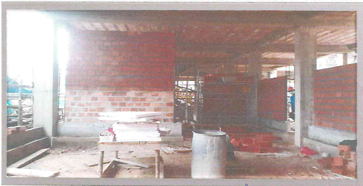
VISTA DE ASENTADO DE LADRILLO EN MOD A
