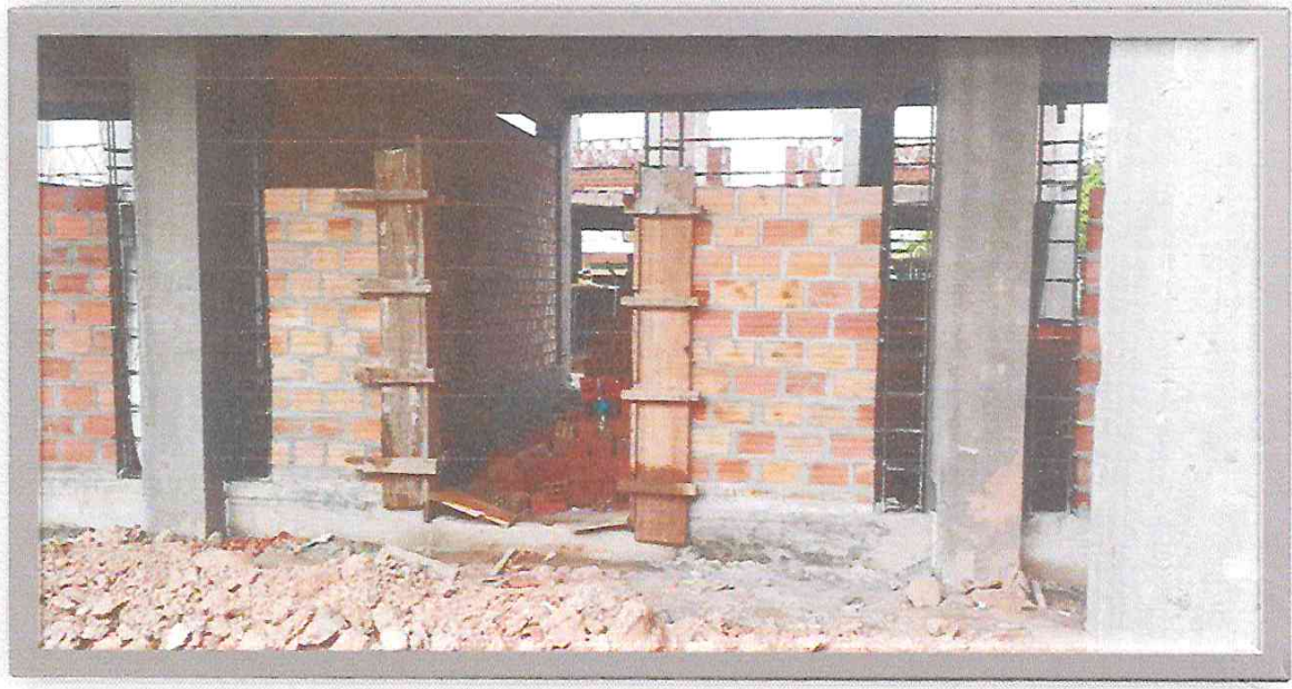
VISTA DE ENCOFRADO DE COLUMNETAS DE MOD C
