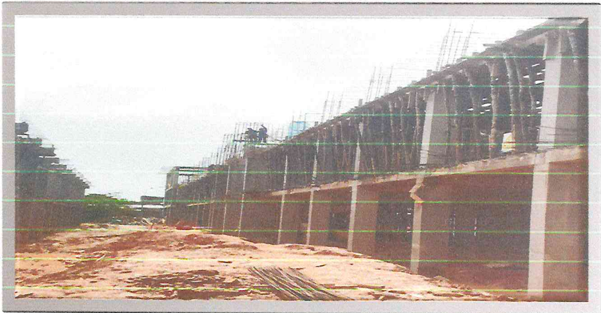
VISTA DE COLOCACION DE ACERO CORRUGADO PARA COLUMNAS EN 3° PISO DE MOD "C"
